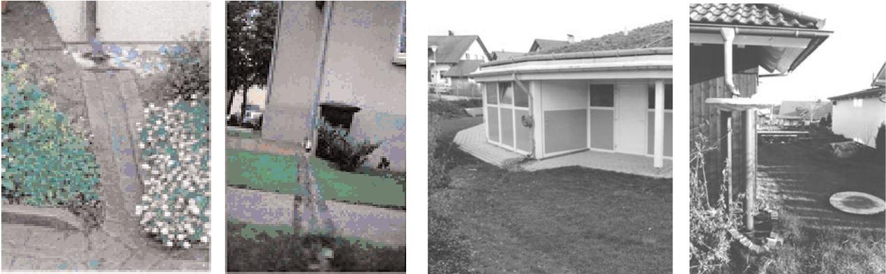
Die oberflächennahen Mulden-, Graben- oder Rinnensysteme lassen sich frühzeitig gut in das städtebauliche Konzept einer Erschließung integrieren und auch als gestalterisches Element nutzen. Dabei kann die getrennte Ableitung direkt beim Fallrohr beginnen.
